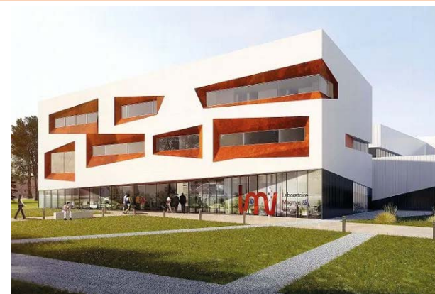
Un bâtiment moderne et fonctionnel :
